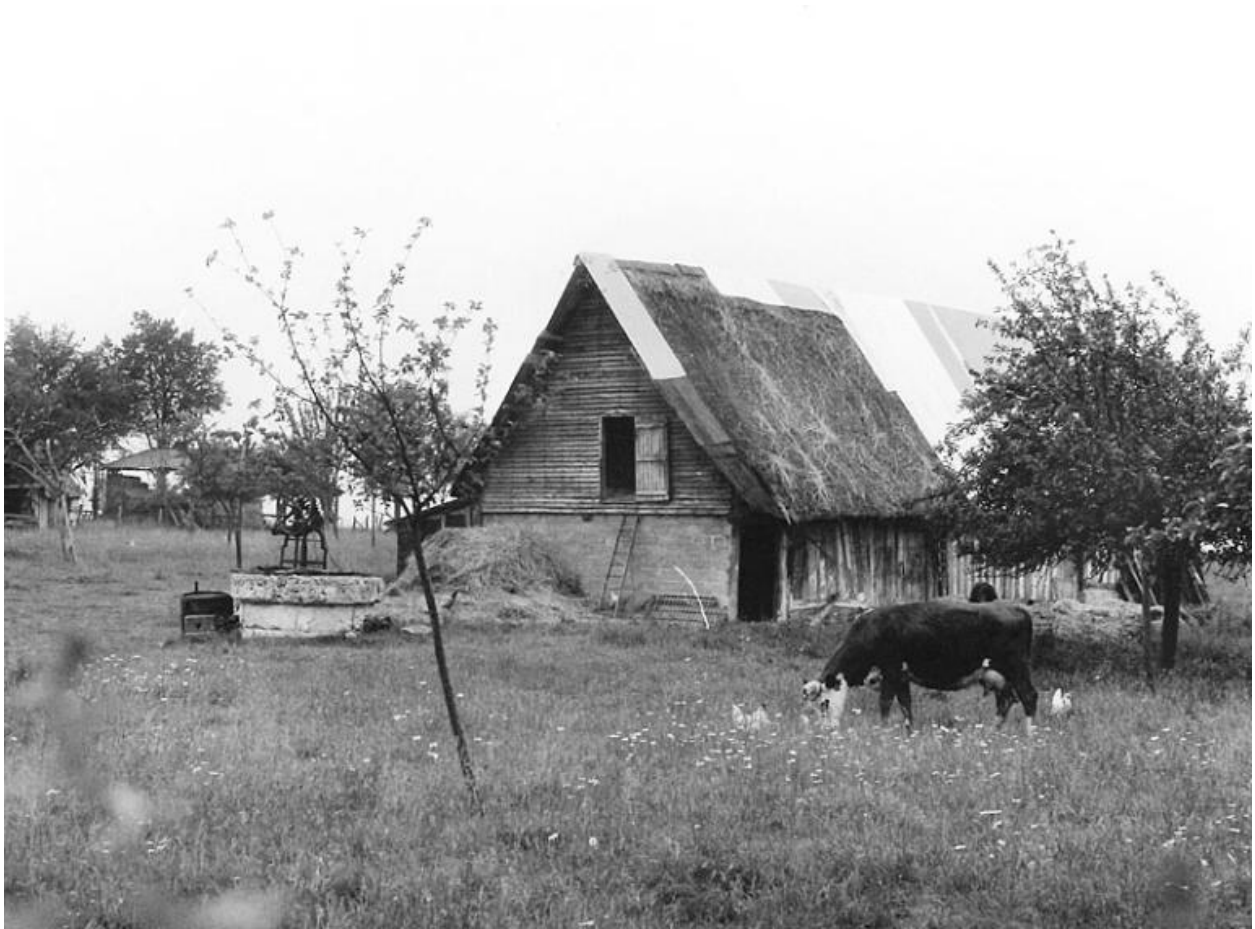
Grange.- Photographie ancienne, inventaire du Parc, 1972.
