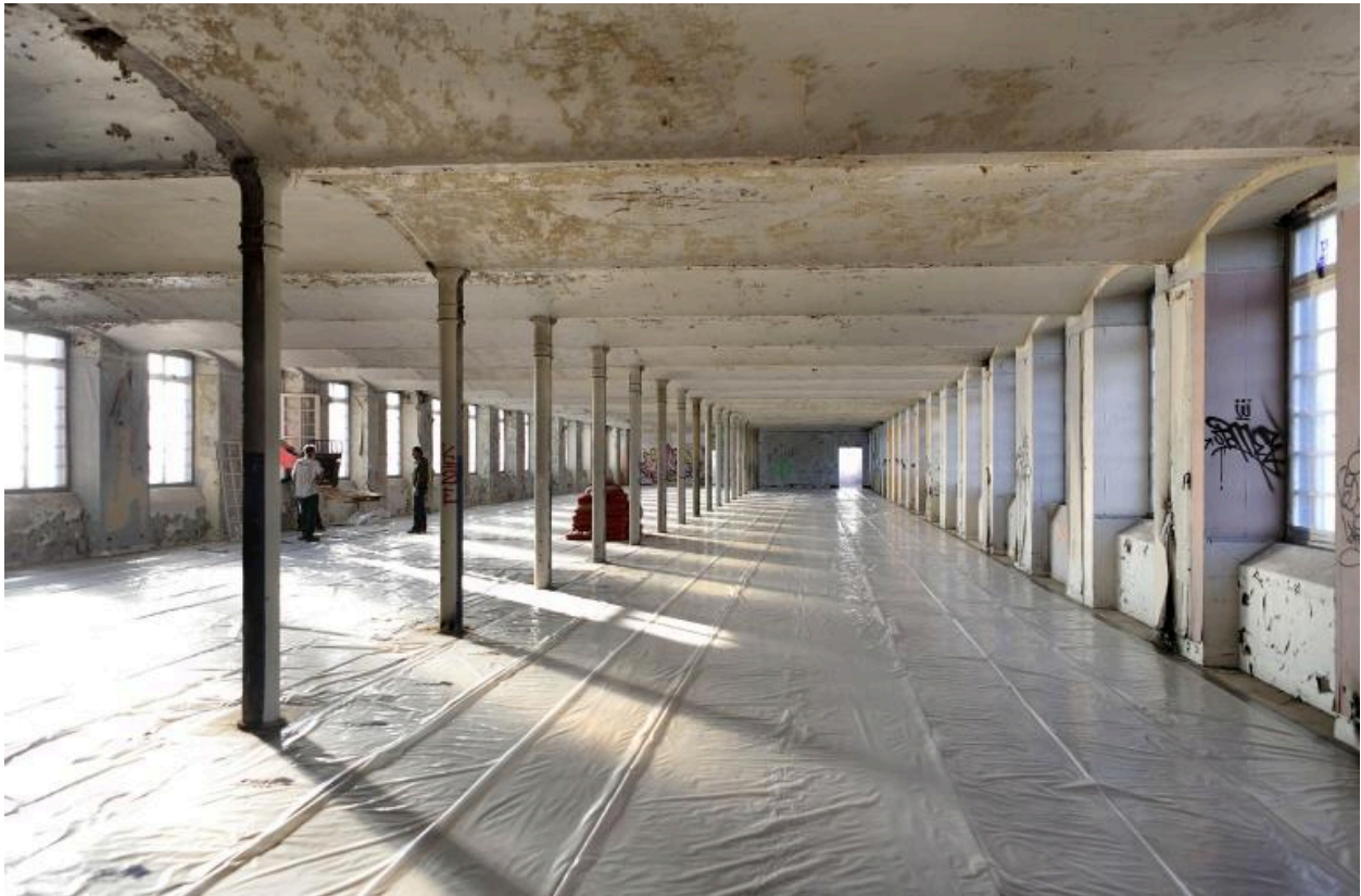
Vue intérieure de la filature, deuxième étage.
