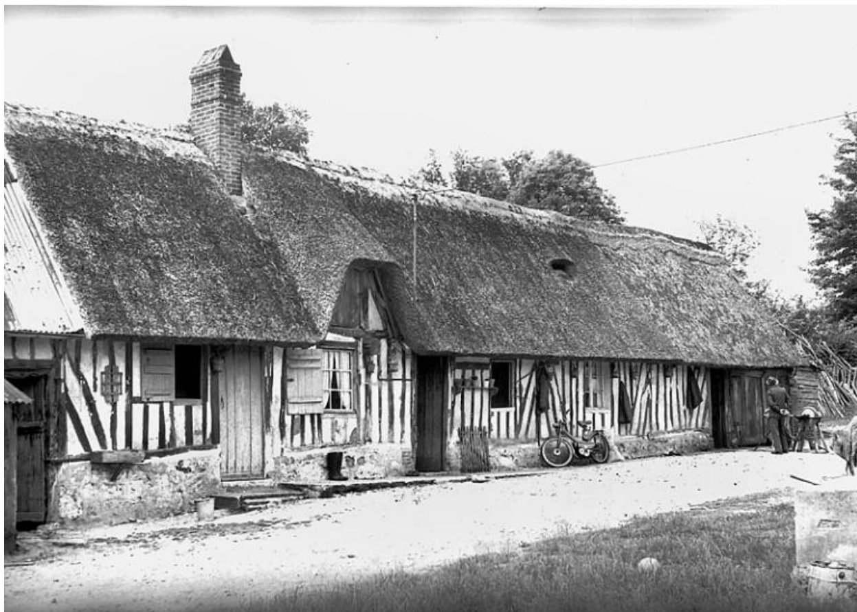
Maison de ferme.- Photographie ancienne, inventaire du Parc, 1972.
