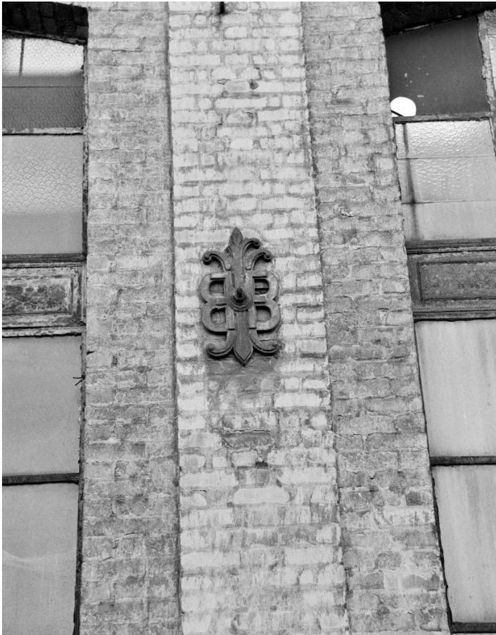
Atelier, détail d'une tête de tirant.
