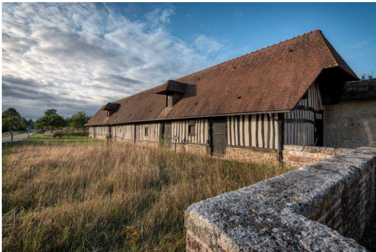
Bâtiment servant autrefois de grange, étable et poulailler, angle nord-est.
