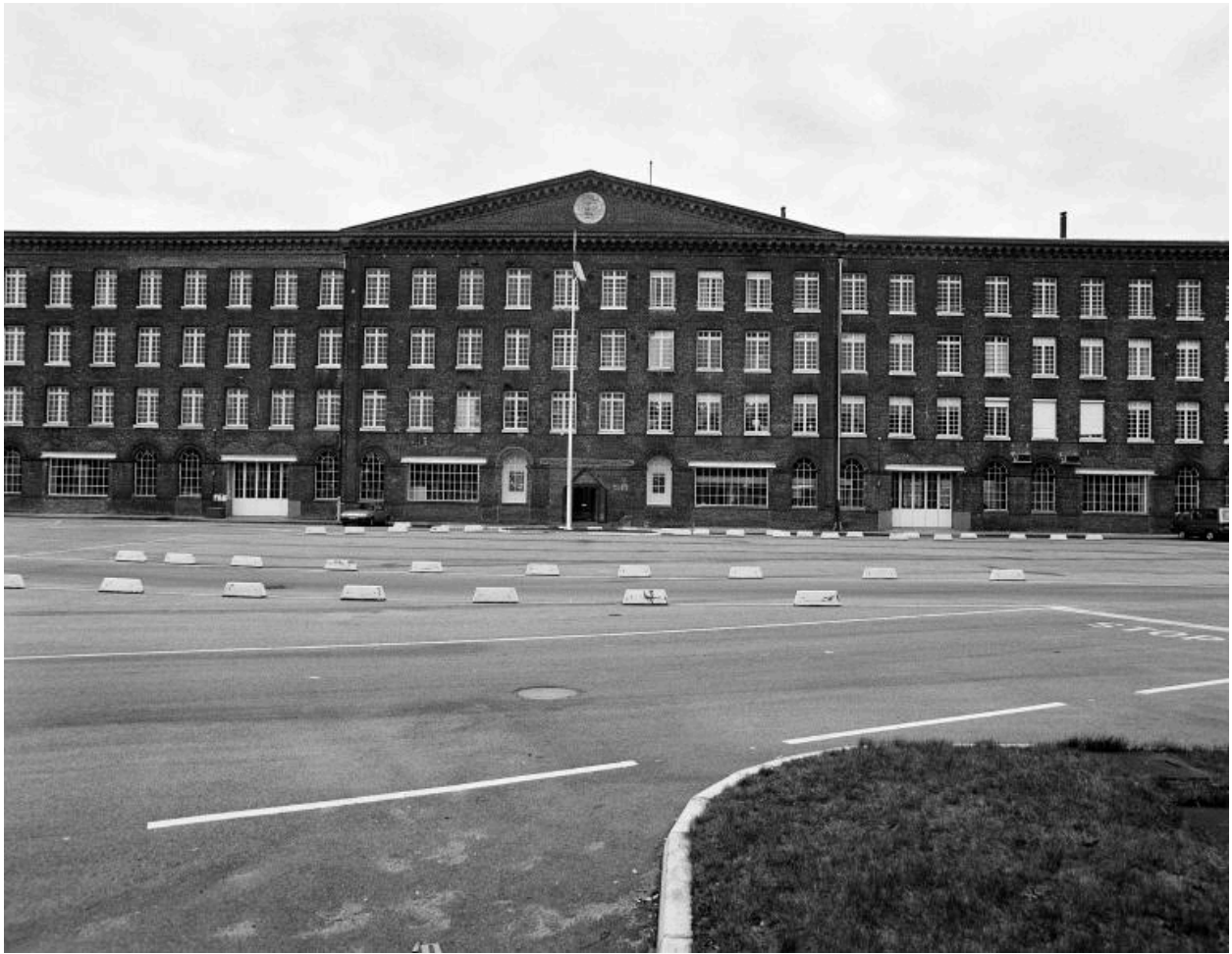
Vue de la façade Ouest de la filature.
