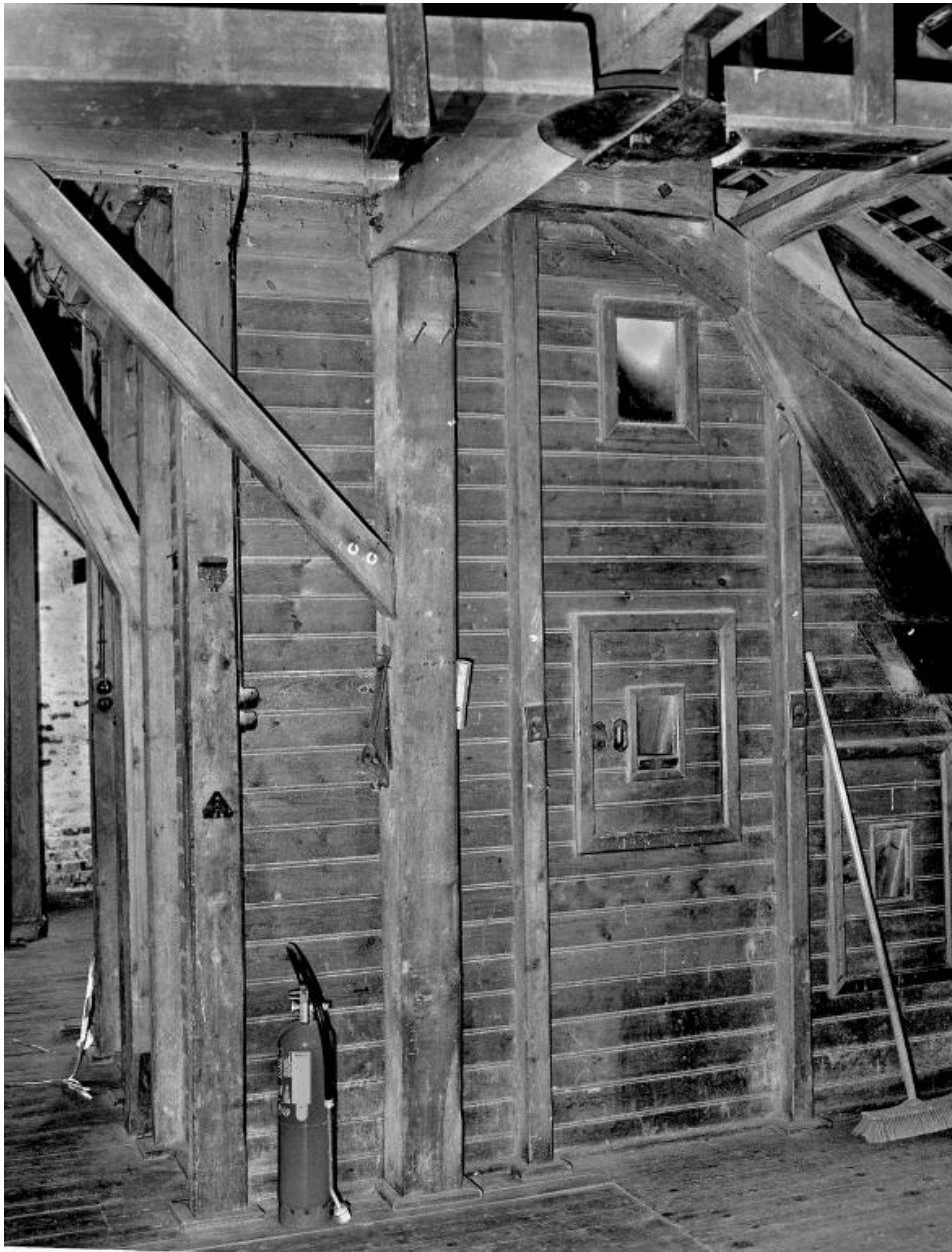
Vue intérieure du 3e étage, silo rectangulaire destiné au stockage du blé avant transformation.
