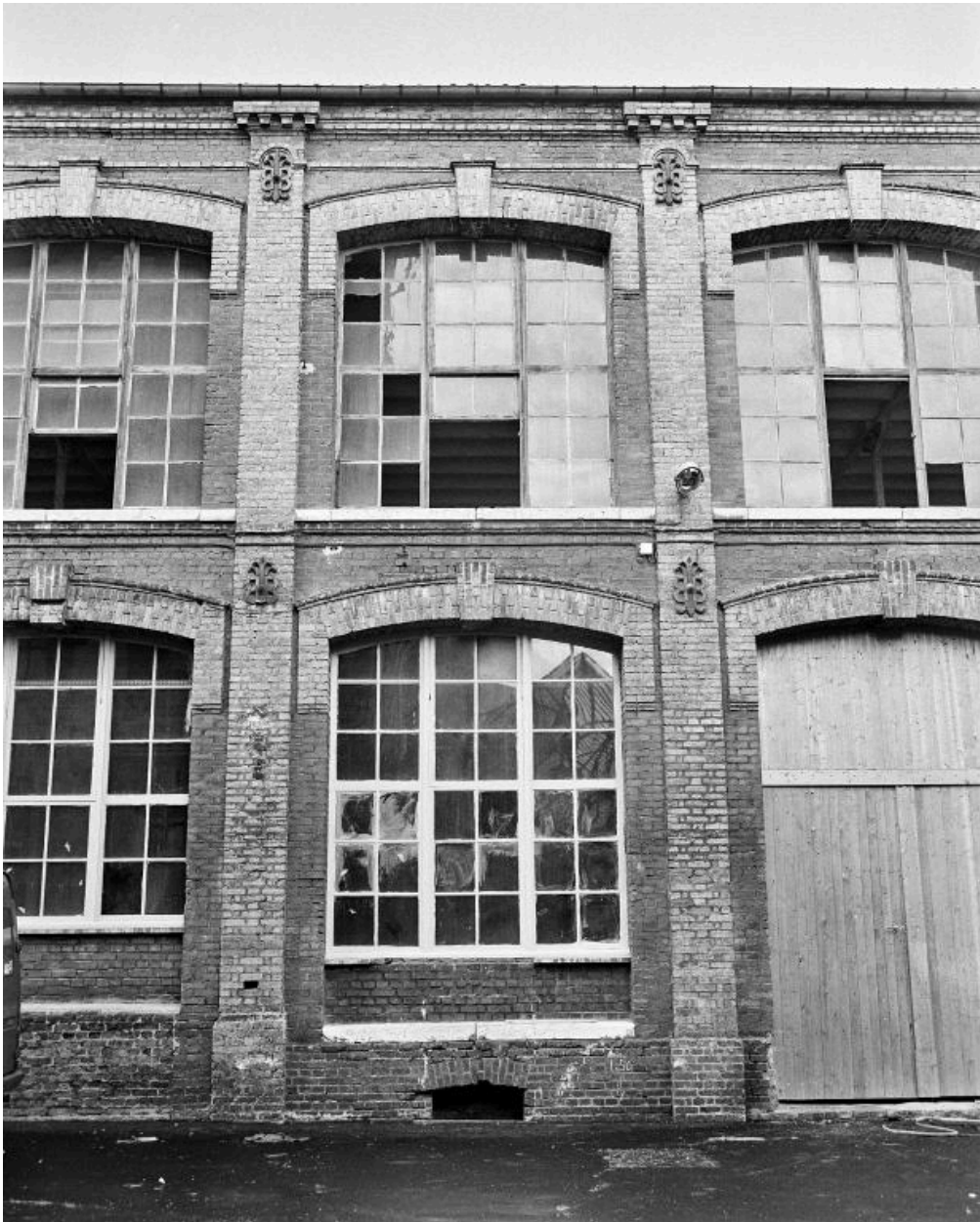
Atelier, détail de travées.
