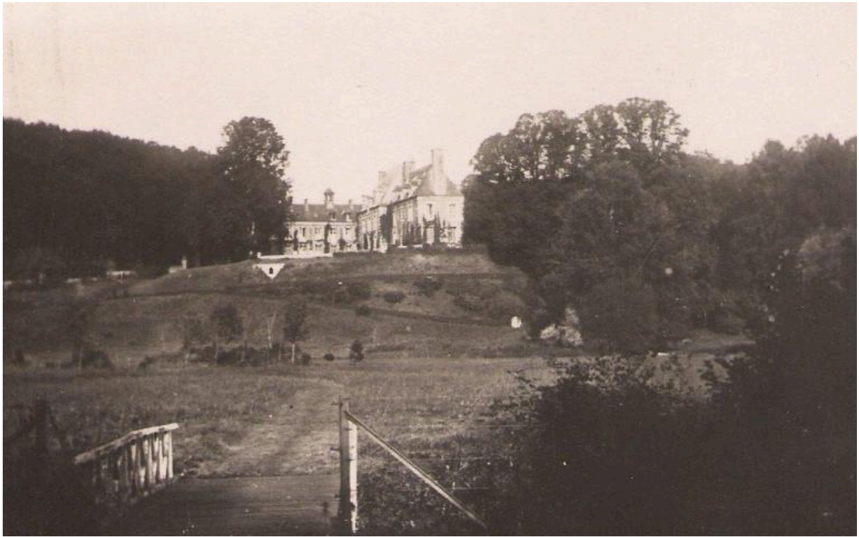
Vue d'ensemble depuis l'est.- Photographie, 1937. (collection particulière).
