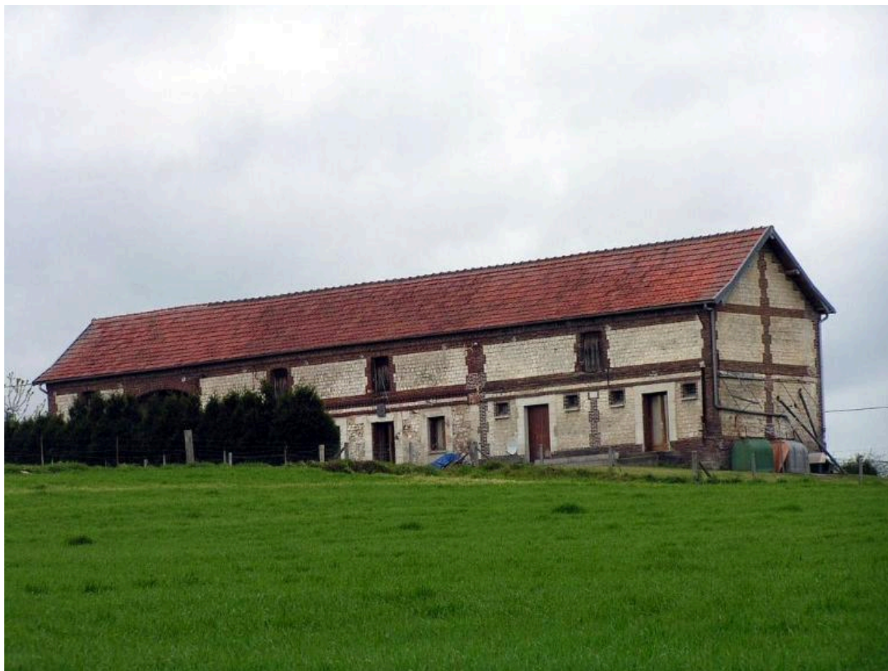
Ancienne grange, vue en 2005.
