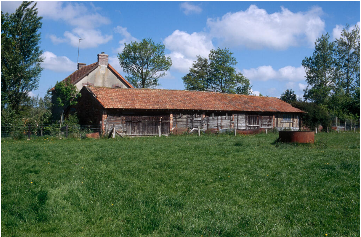
Pièce de séchage, atelier de fabrication et logement. Vue prise du sud.
