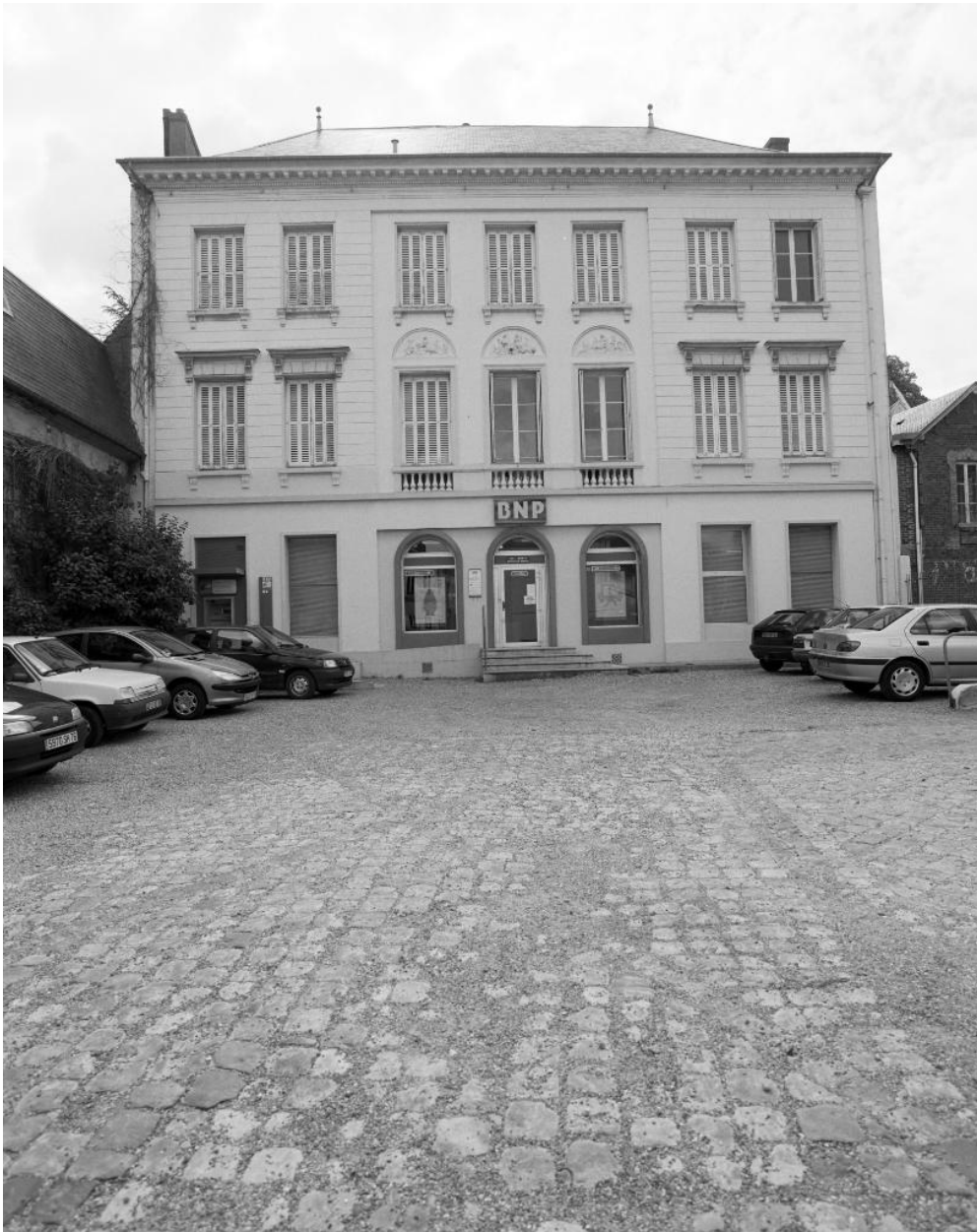
Vue générale de la façade sur cour du logement patronal.
