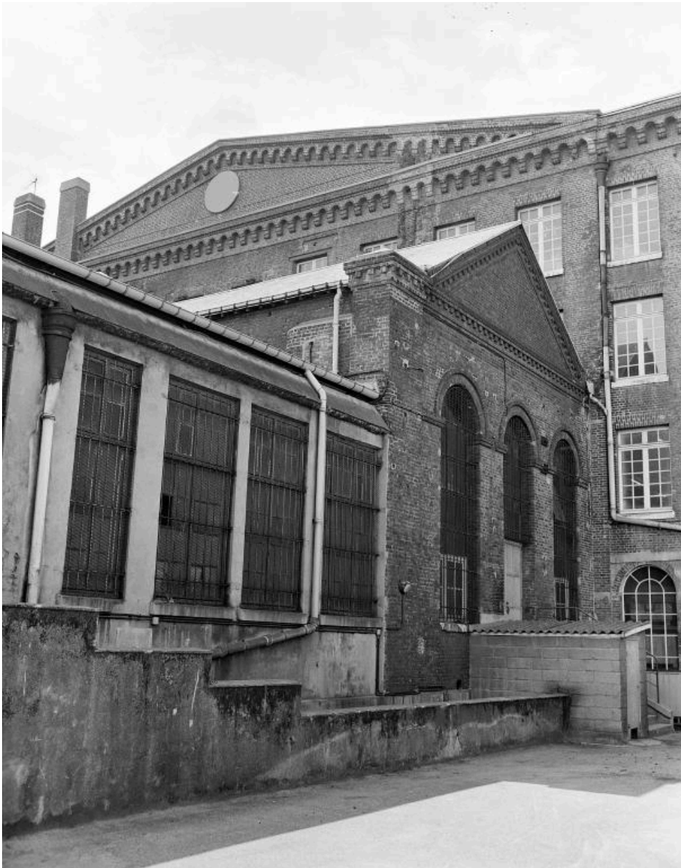
Vue du pignon Nord de la salle des machines attenante à la façade Est de la filature.
