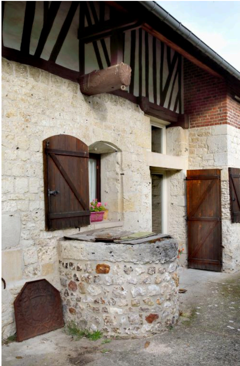
Façade sud, détail du puits.
