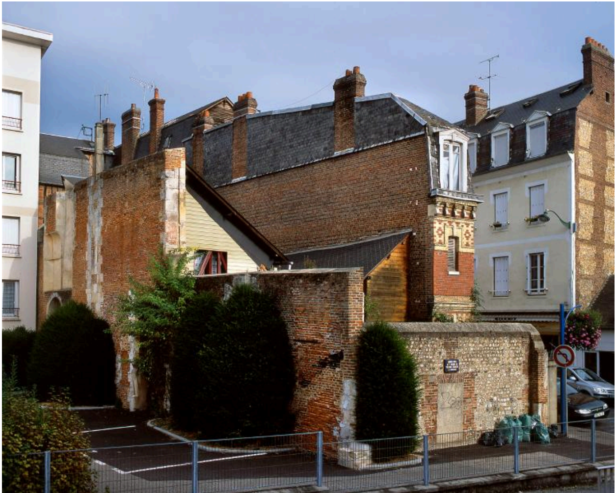
Façade postérieure donnant sur un passage.
