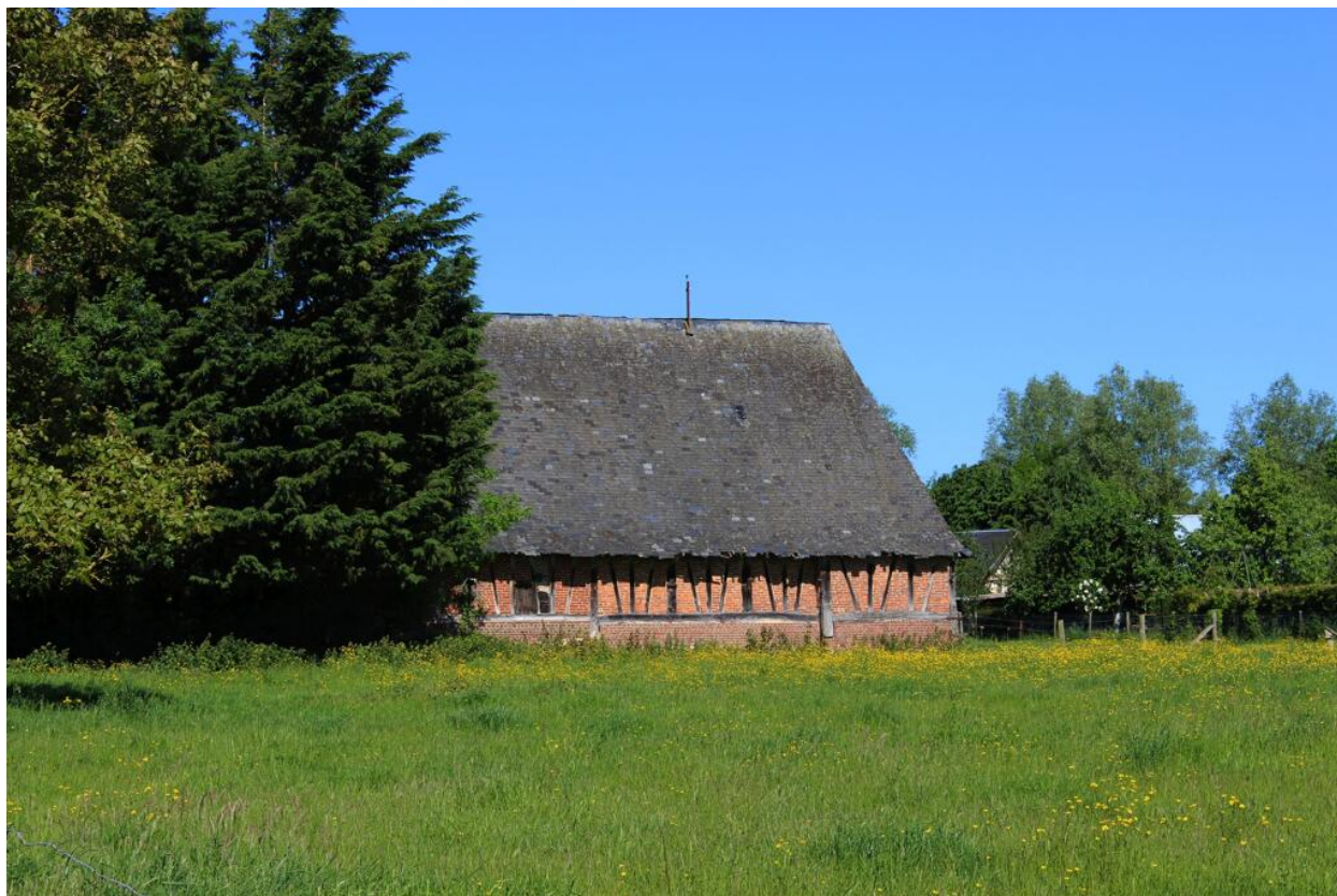
Grange, façade est.
