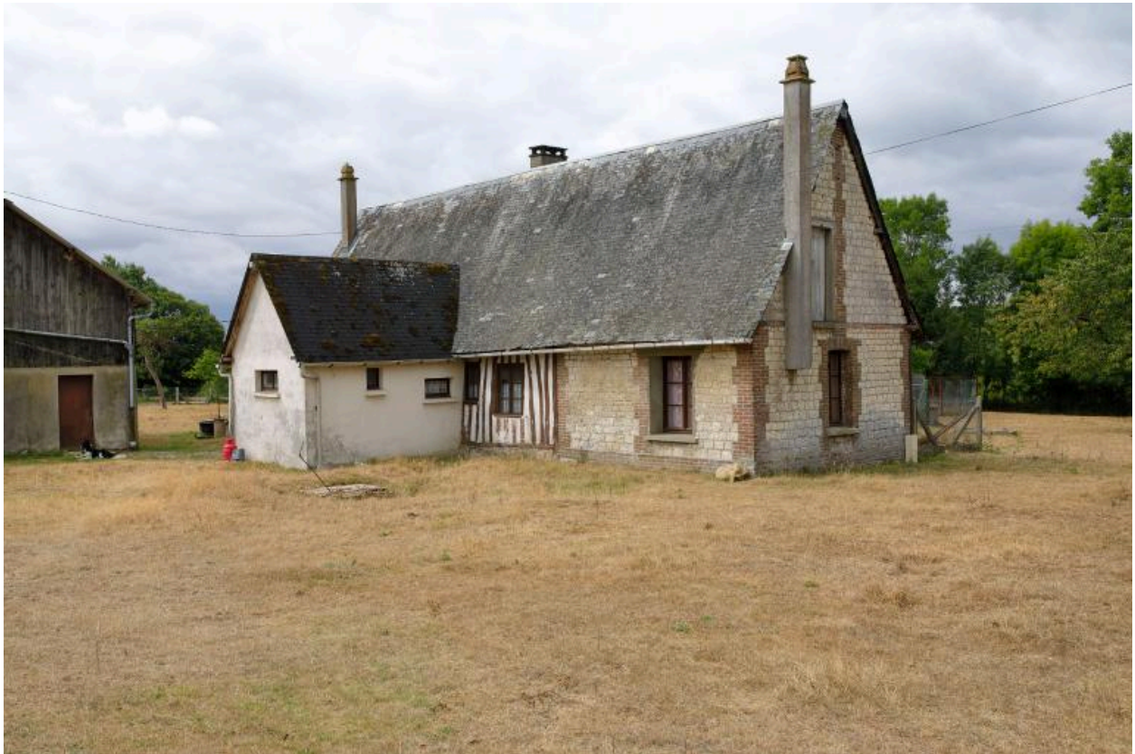
Ancienne maison de ferme, 431 rue du château, angle nord-est.
