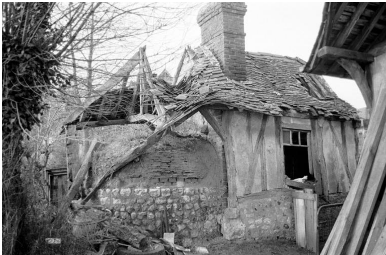
Four à pain, actuellement détruit.- Photographie ancienne, inventaire du Parc, 1972.
