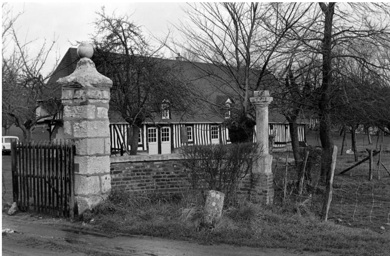
Entrée principale du corps de ferme.- Photographie de l'Inventaire général, 1974.
