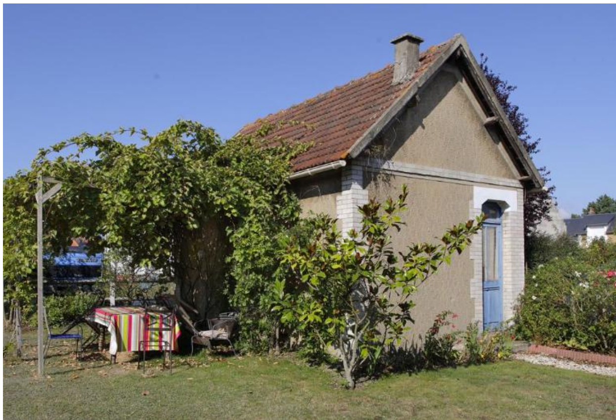
Ancien bureau, angle sud-est.
