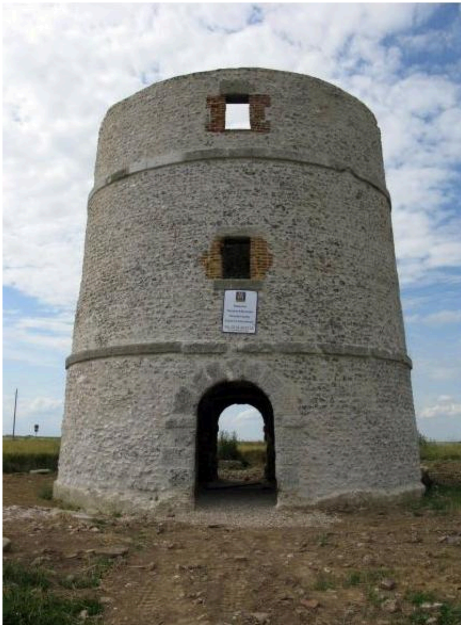
La tour du moulin après restauration.
