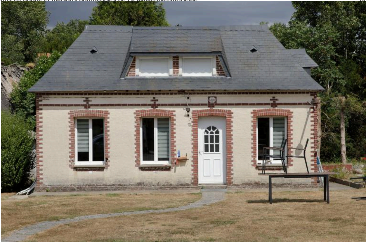
Maison datée 1898, chemin du moulin, hameau de Caveaumont.
