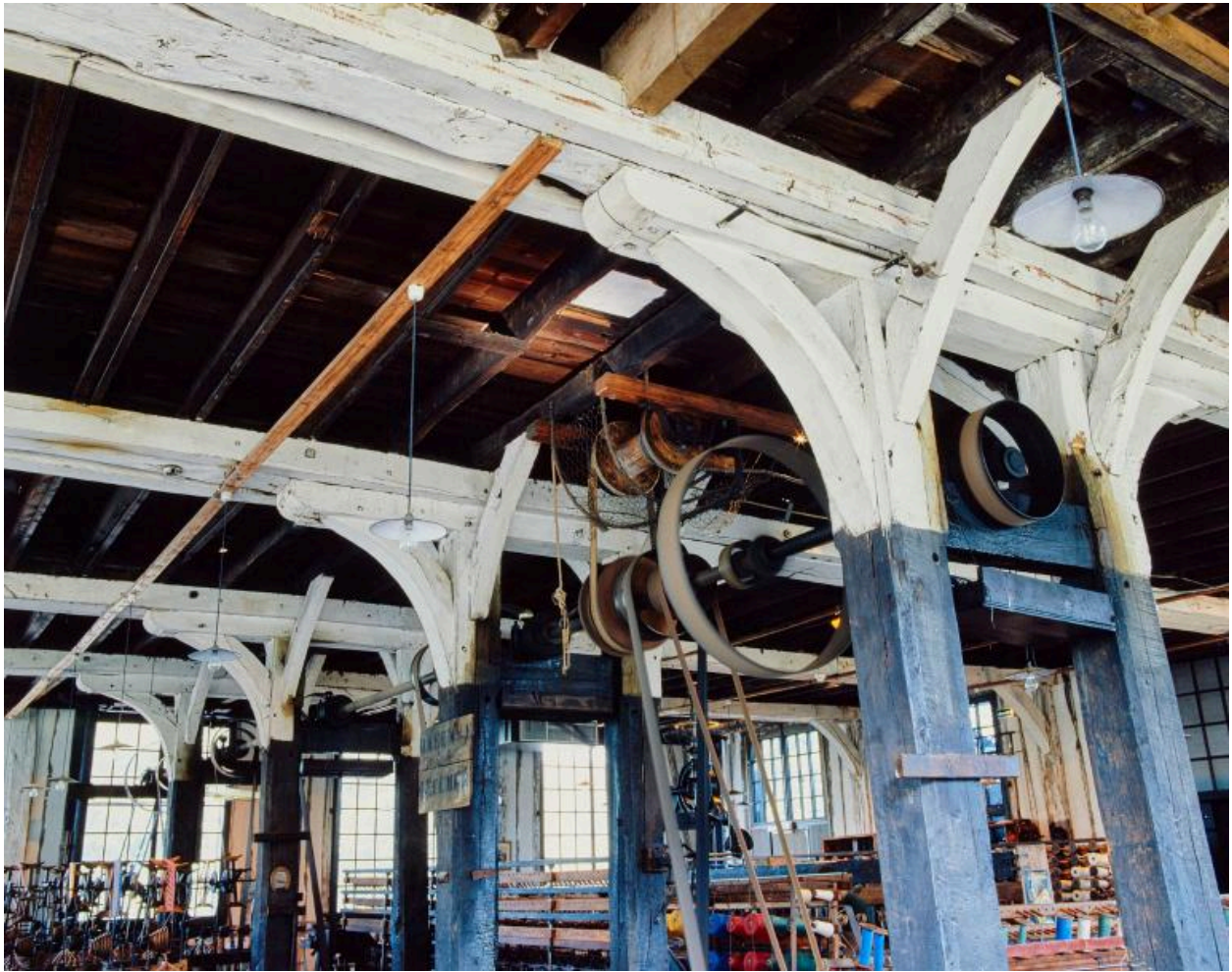
Vue intérieure, premier étage, charpente et arbre de transmission.
