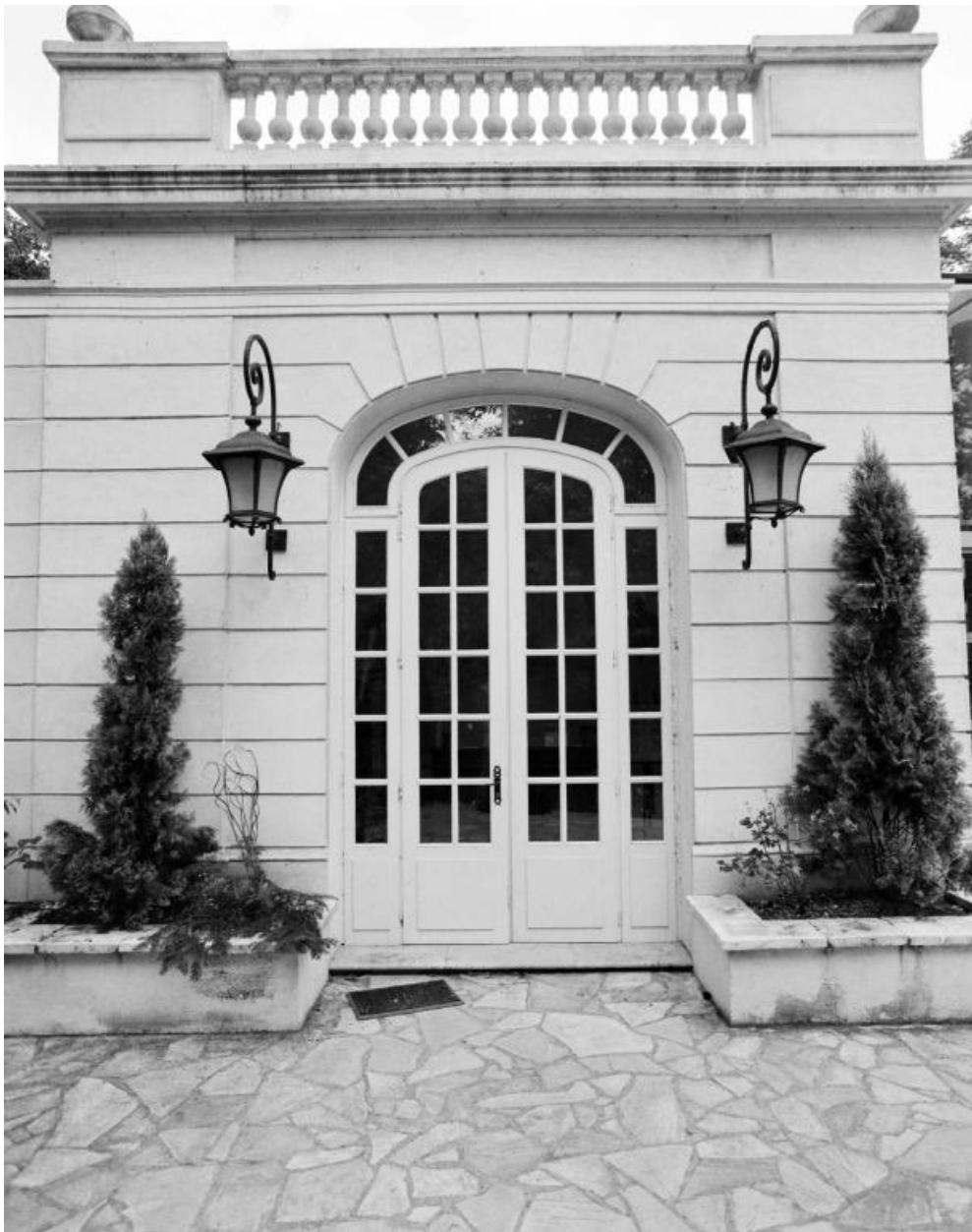
Théâtre, vue extérieur, détail d'une porte.
