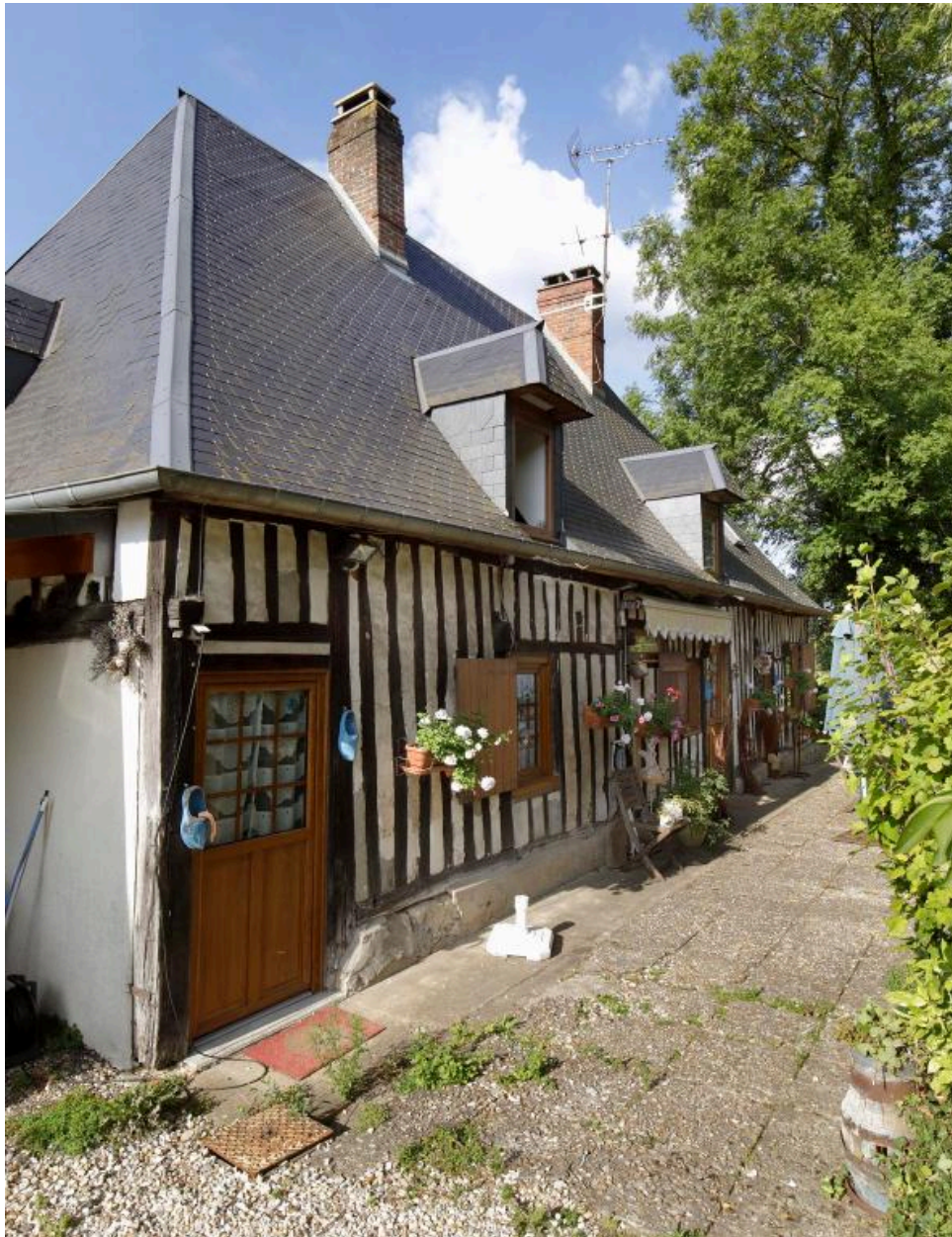
Ancienne maison de ferme, 1225 rue du Wuy, angle sud-est.
