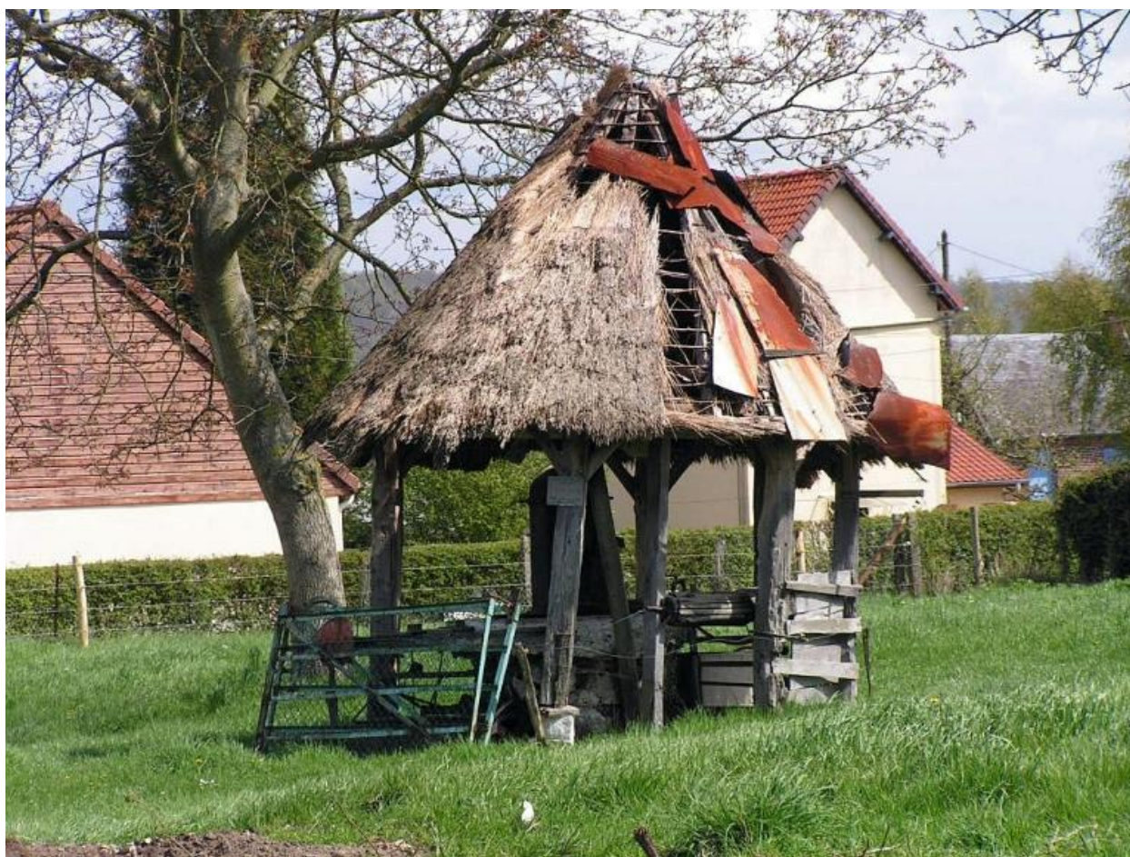
Puits couvert en chaume, vu en 2005.
