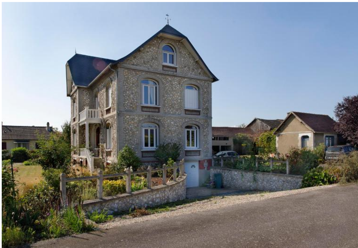
Maison du directeur, pignon nord.
