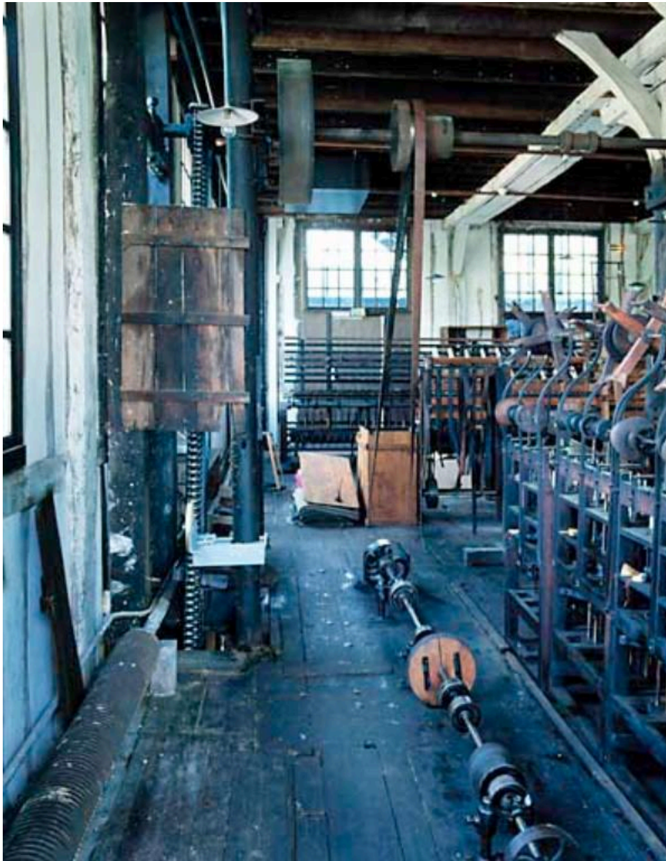
Vue intérieure, premier étage, arbre de transmission.
