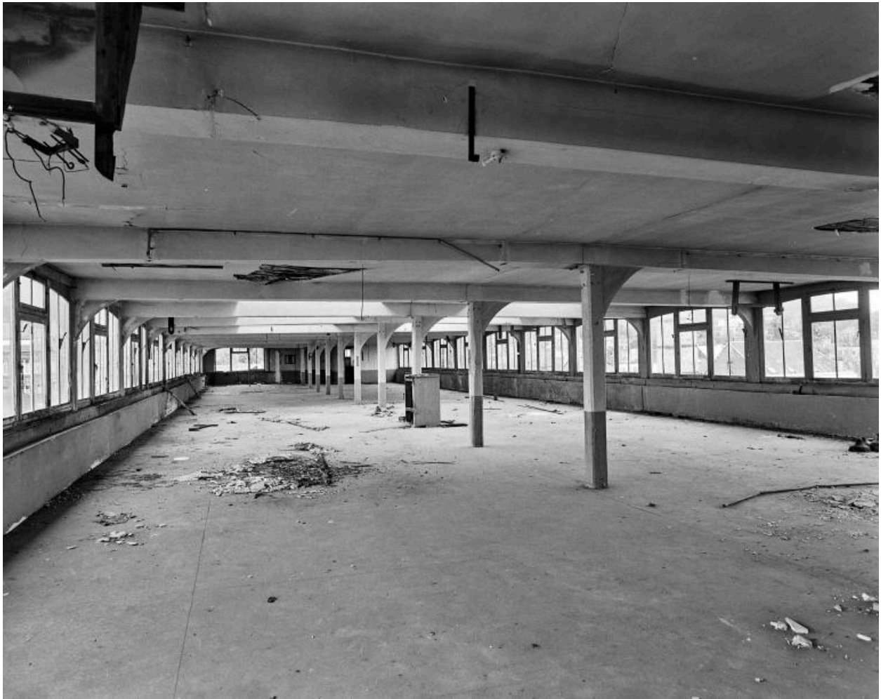
Vue intérieure de l'atelier de fabrication (bâtiment C du plan légendé) : quatrième étage.
