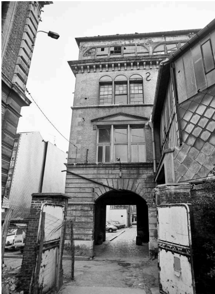
Vue de la filature (bâtiment Est), façade Nord.
