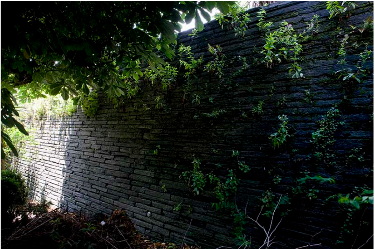
Ancien mur d'enceinte. Détail de l'appareillage.
