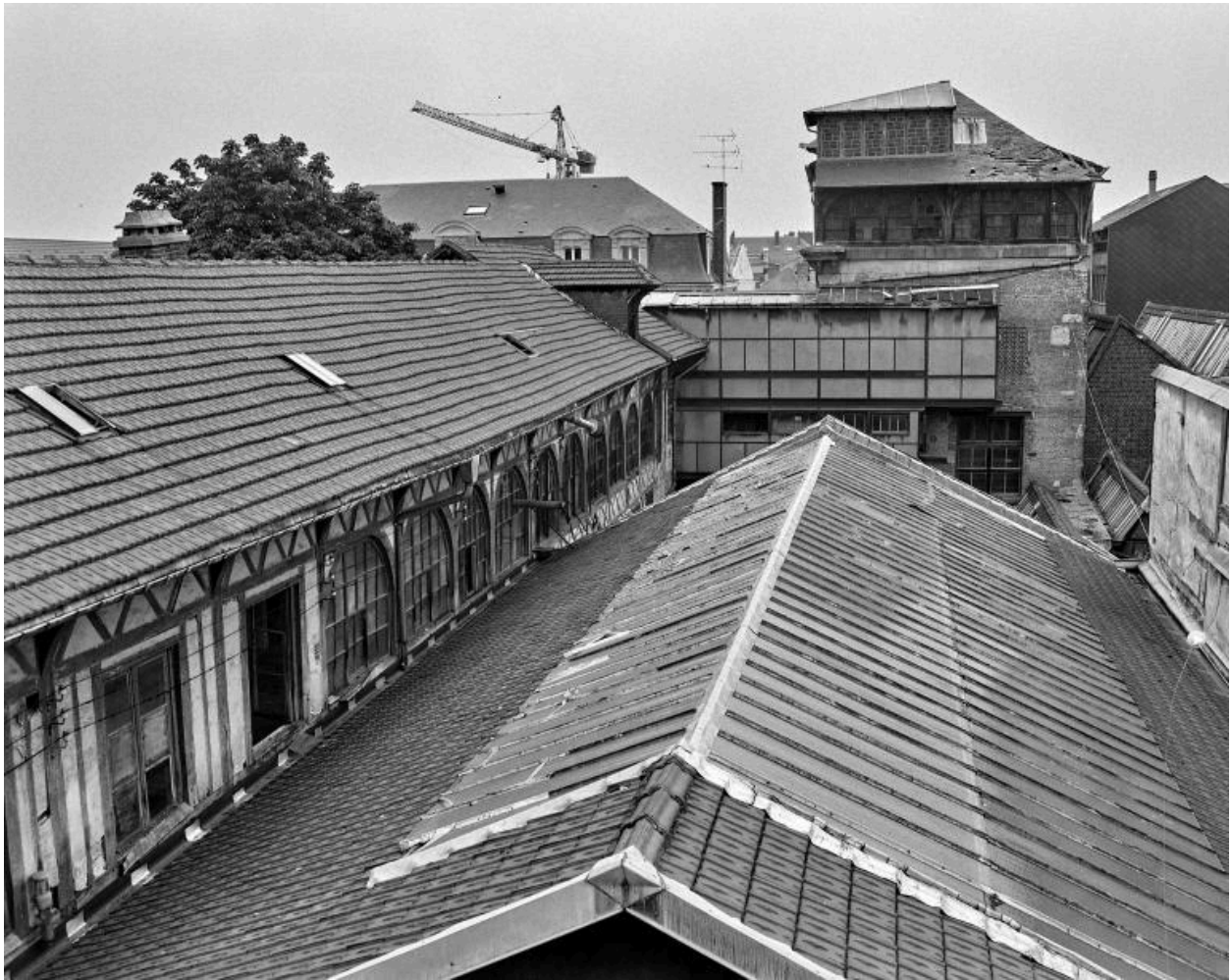
Vue de cour intérieure couverte depuis le logement patronal.
