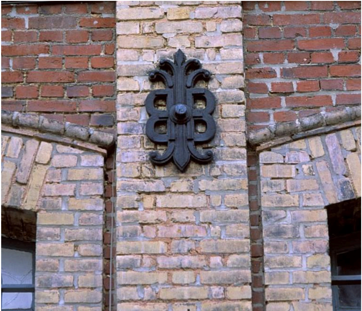
Atelier, détail d'une tête de tirant.
