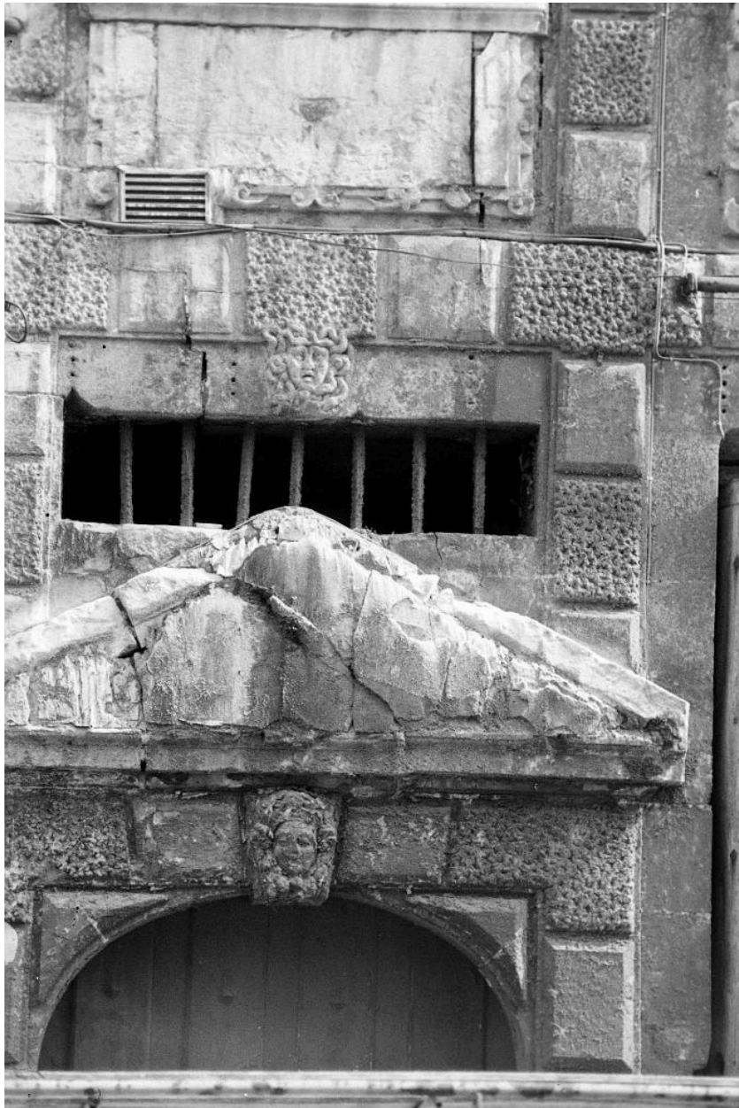
Façade sud, premier niveau, détail du fronton surmontant la porte.
