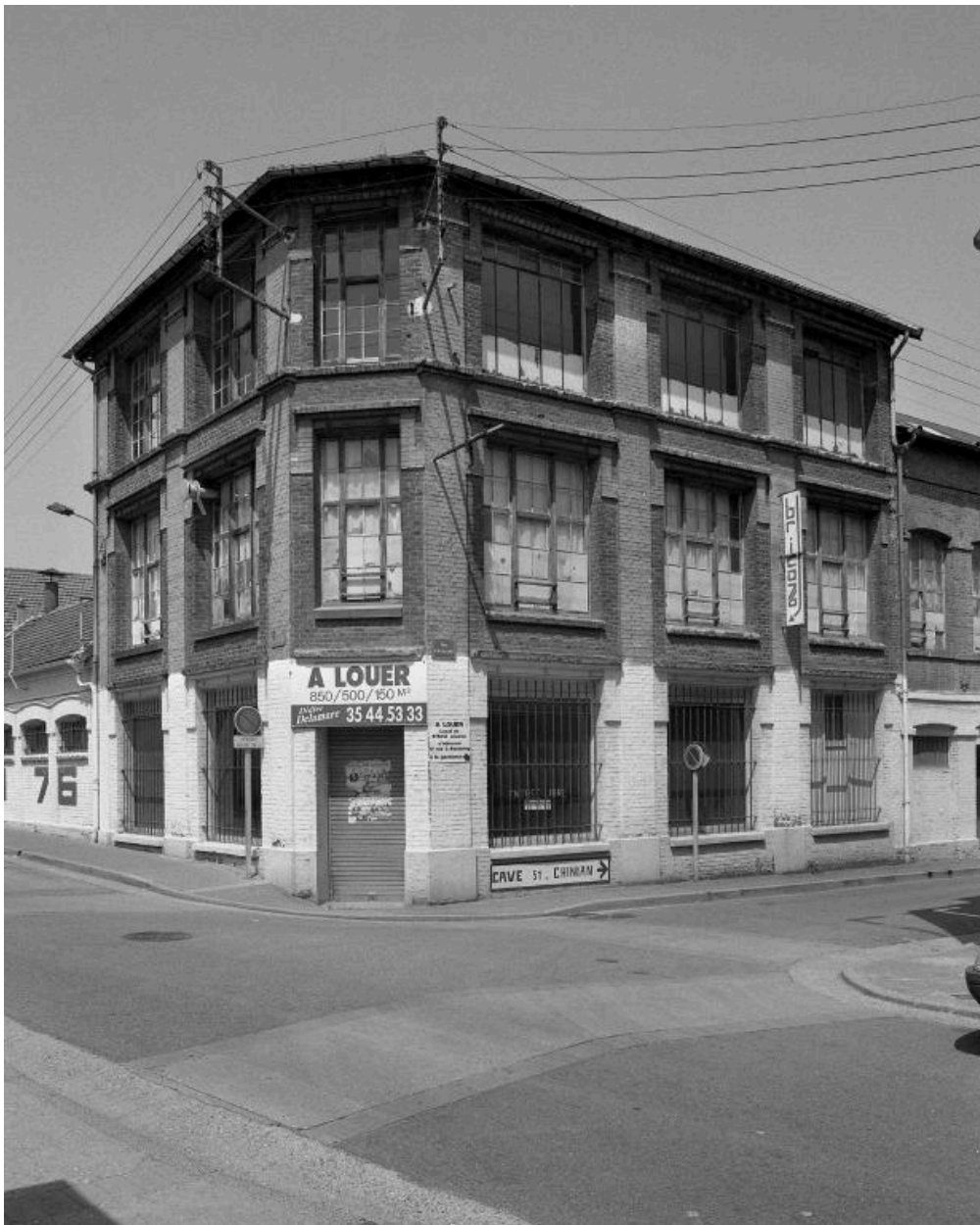
Atelier de fabrication (bâtiment F du plan légendé), élévations Sud et Est sur les rues Salvandy et Patllier.
