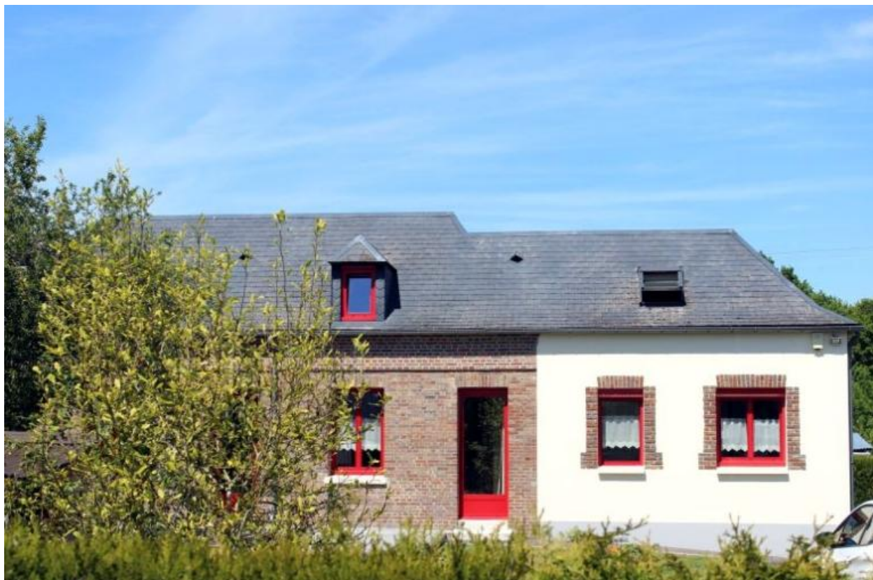
Longère, impasse du vieux Pas, chemin du Pas Grillant.
