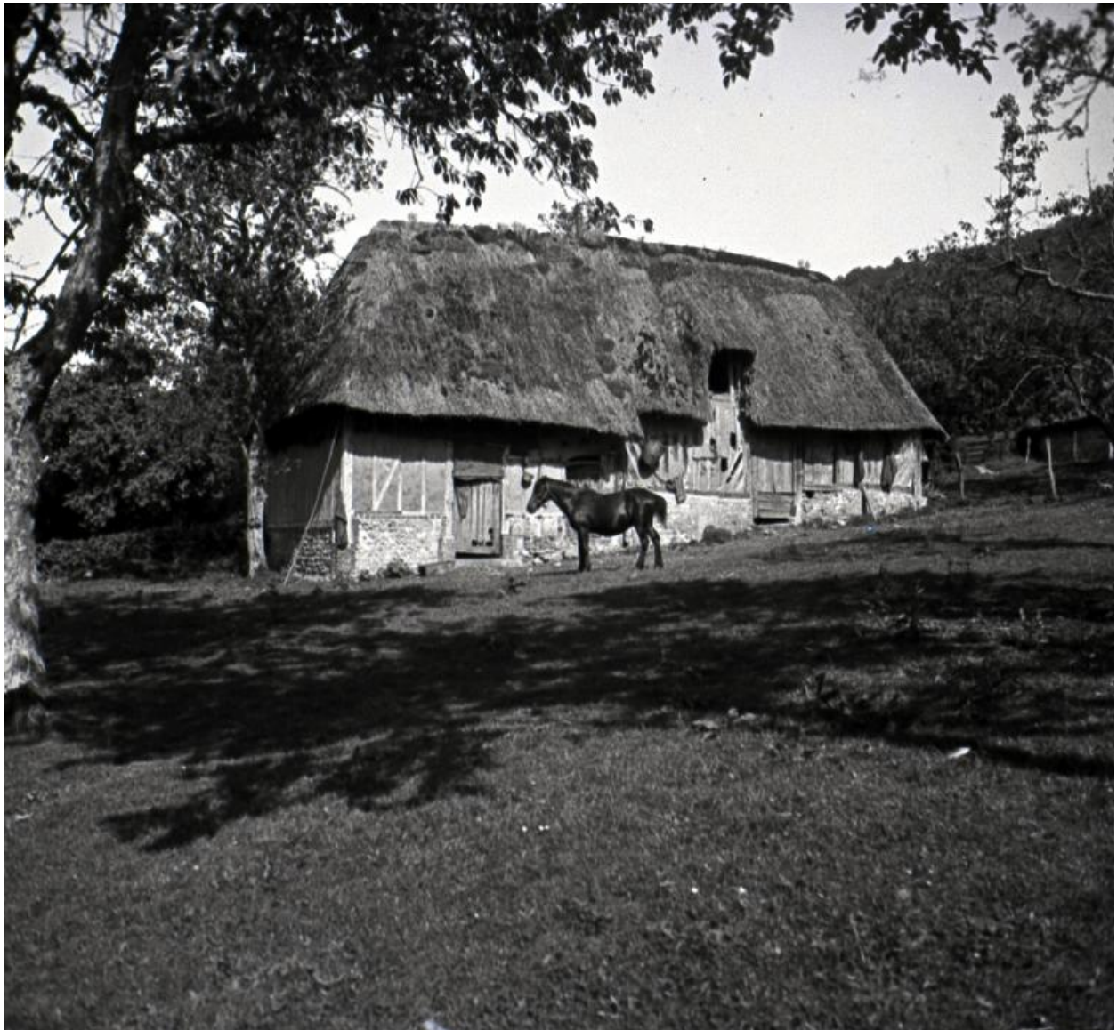
Ancienne écurie (détruite).- Photographie, fonds Robert Eude, vers 1950 (AD Seine-Maritime, 11 Fi).
