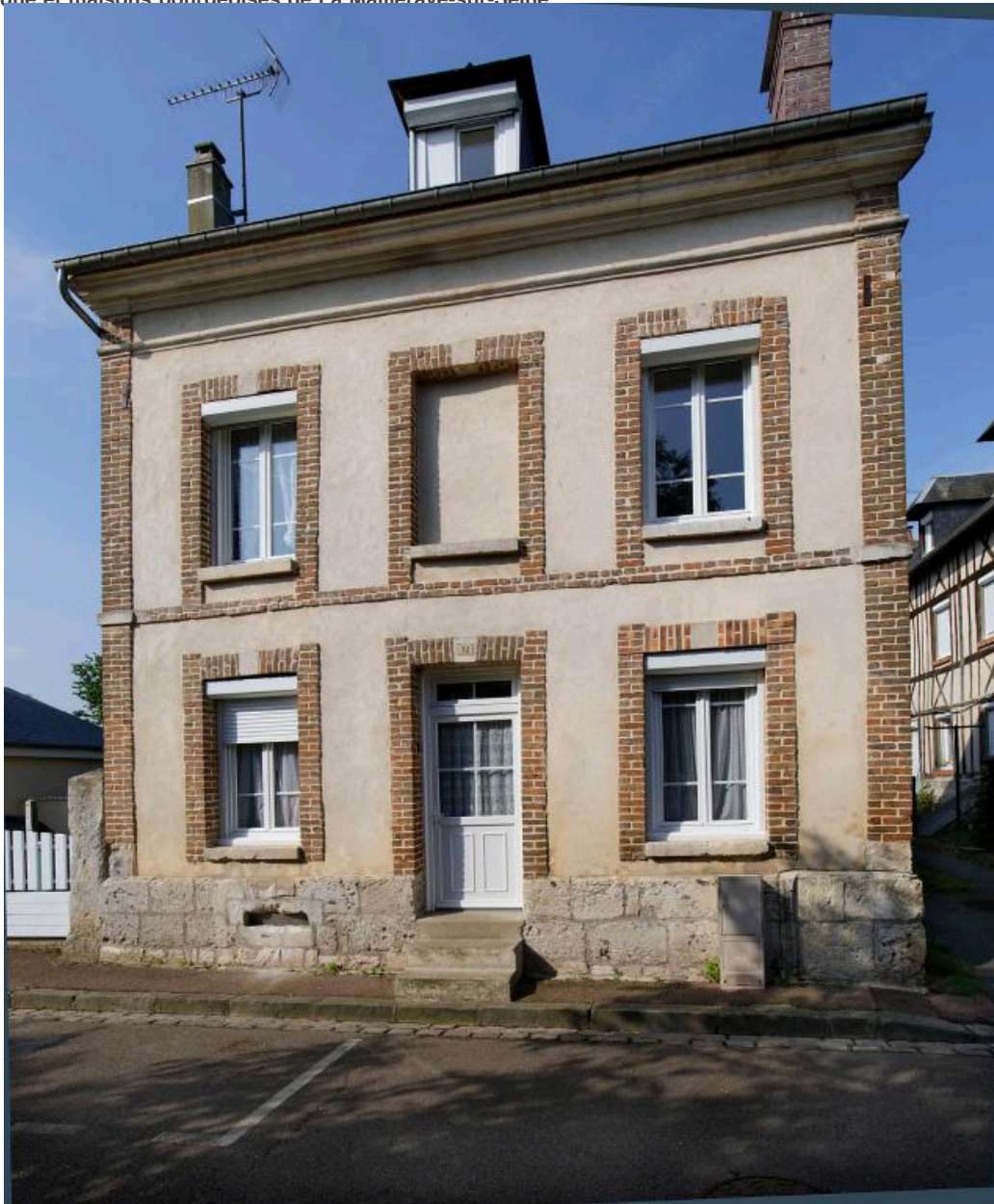
Maison de ville, 32 rue de l'église, façade est.
