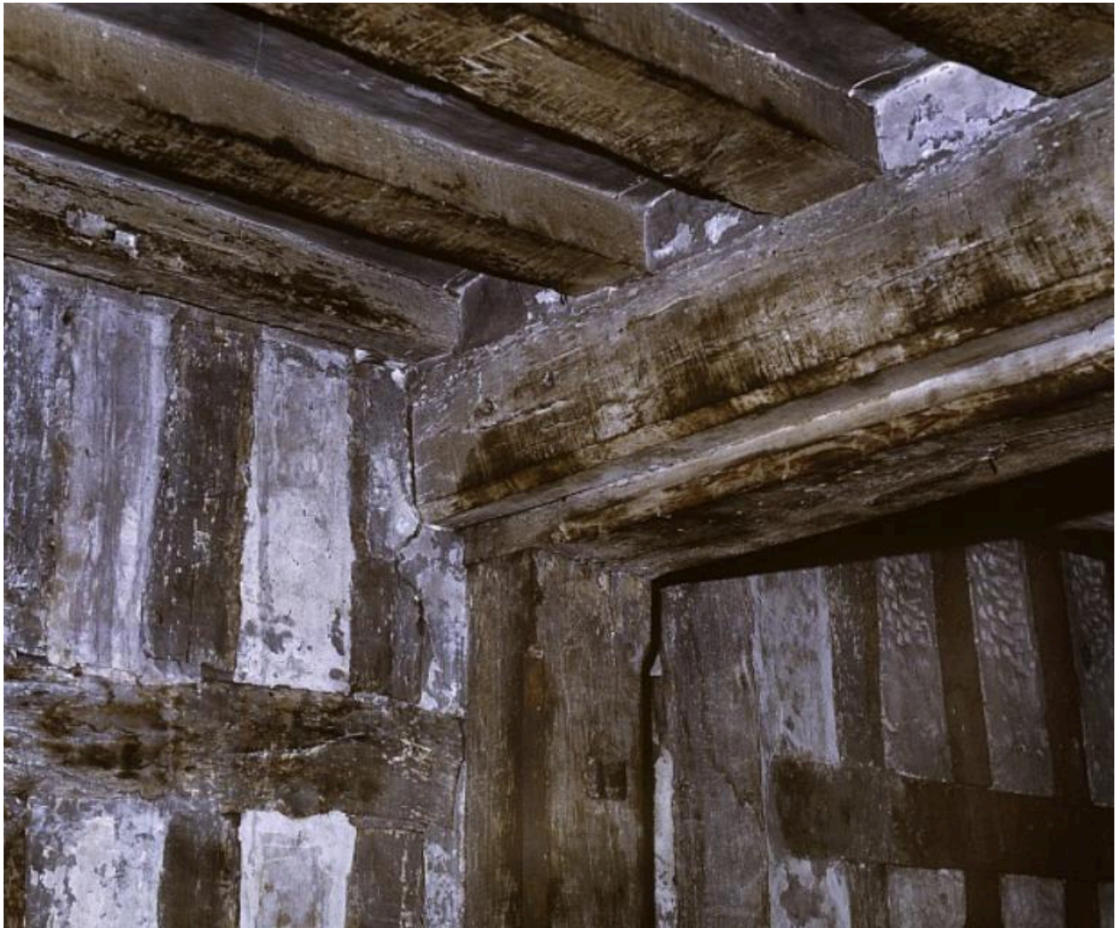
Vue intérieure du tissage (bâtiment Nord), second niveau, détail de la charpente.
