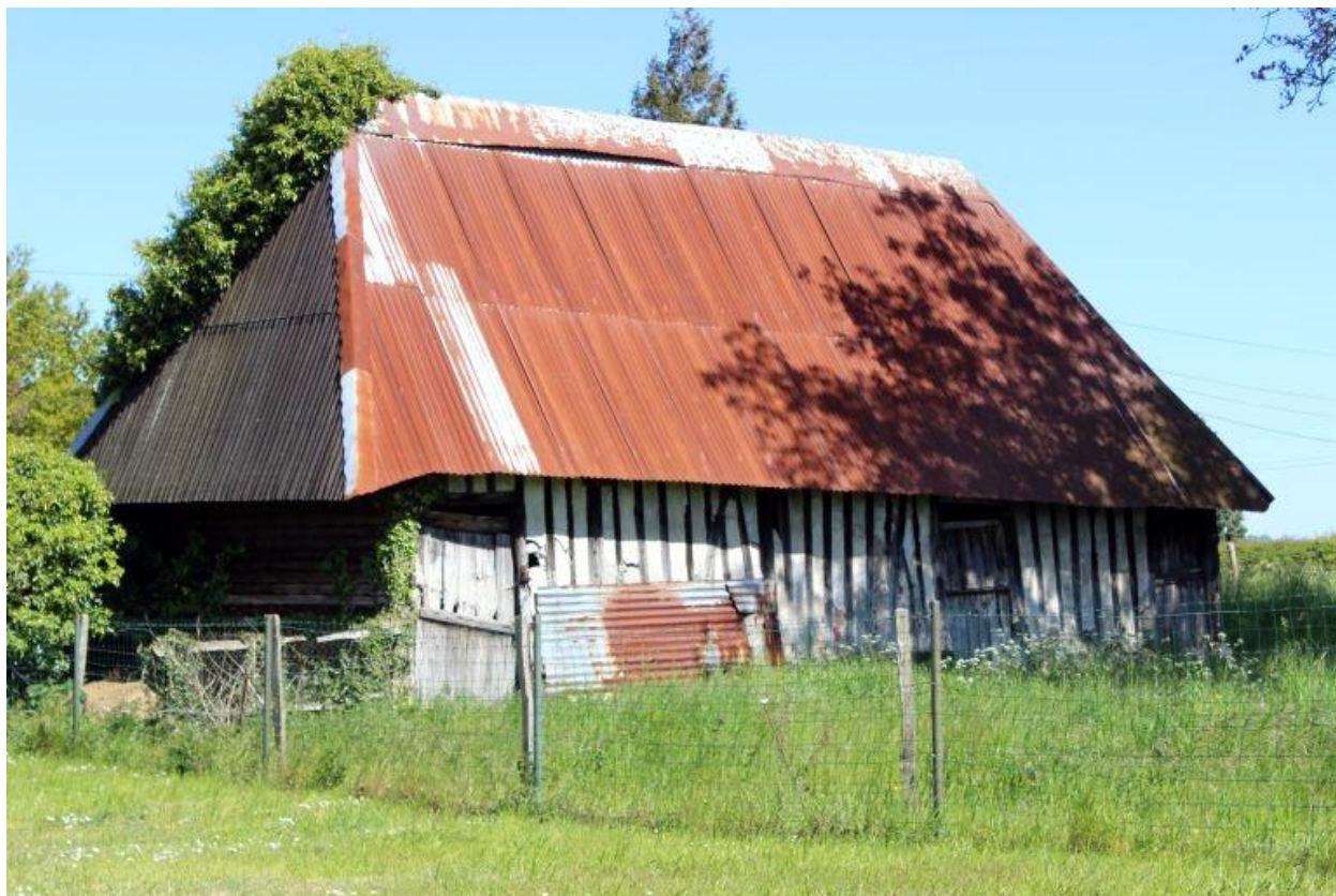
Petite grange, façade ouest.
