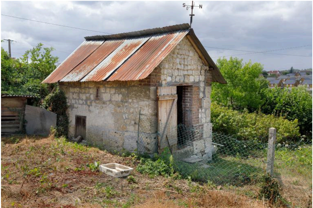
Ancien poulailler, 88 rue du Bourg à Charrol, angle nord-est.
