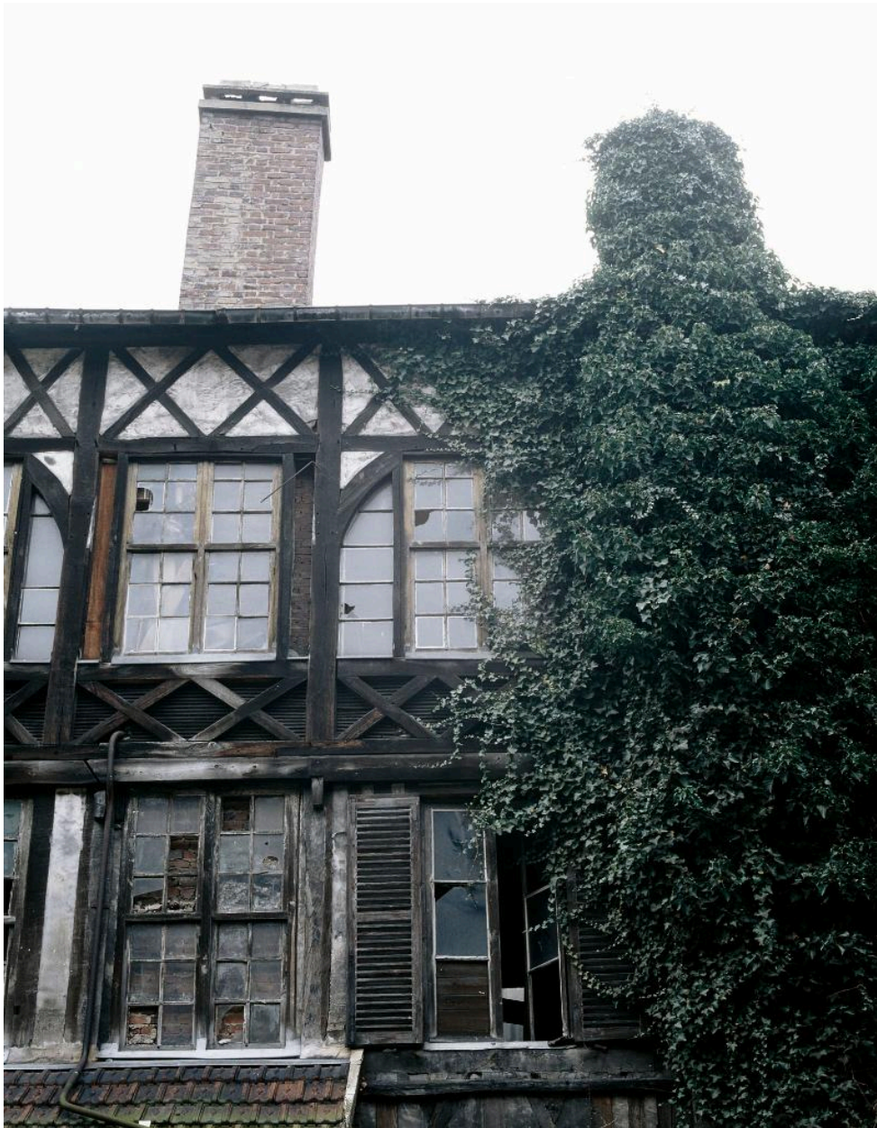
Vue du tissage (bâtiment Nord), détail de la façade Nord.
