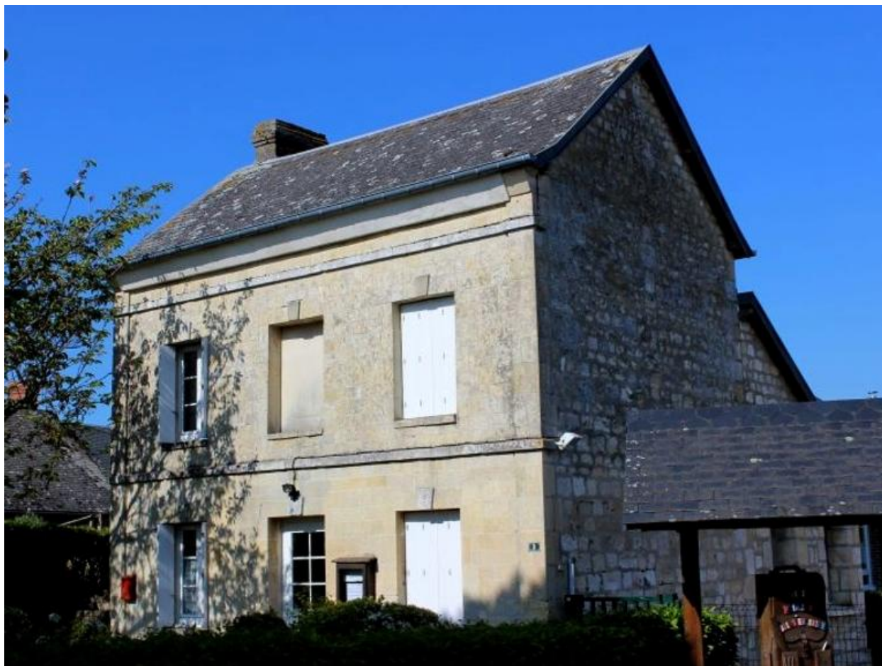
Maison en moellons calcaire à l'entrée de la cour de récréation, angle sud-ouest.
