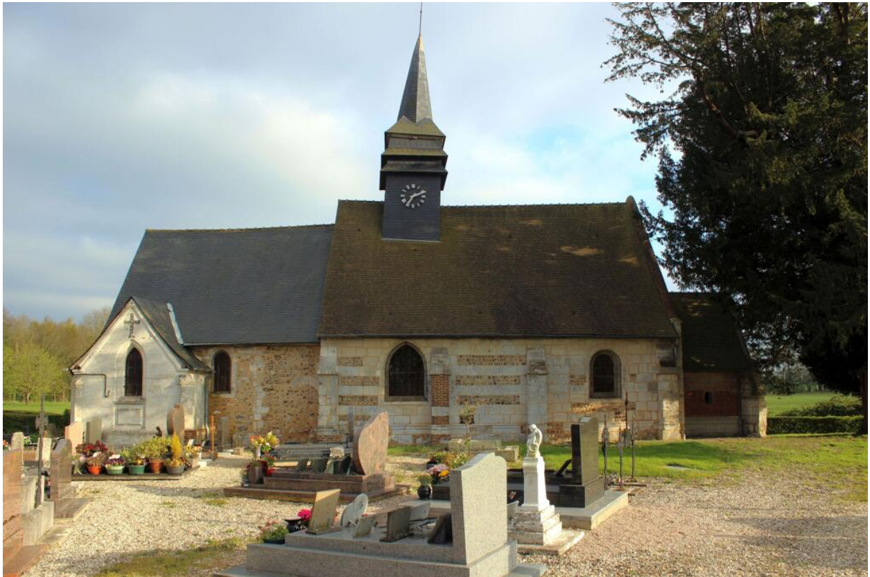
Vue d'ensemble, côté nord.
