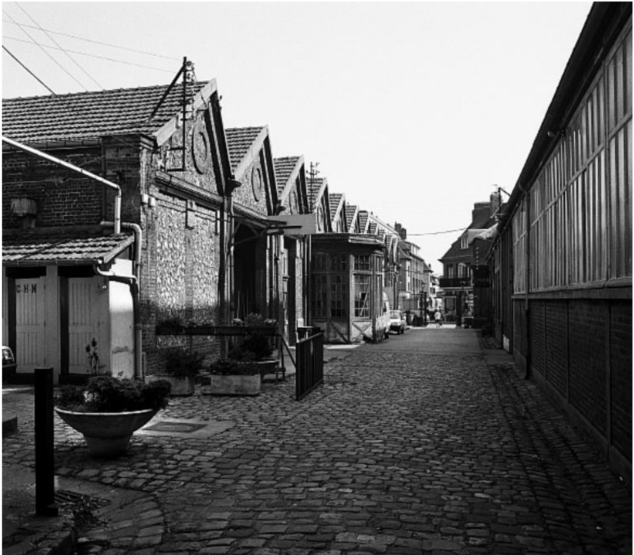
Cour intérieure de l'usine, depuis le Sud, à gauche le tissage (bâtiment K du plan légendé).
