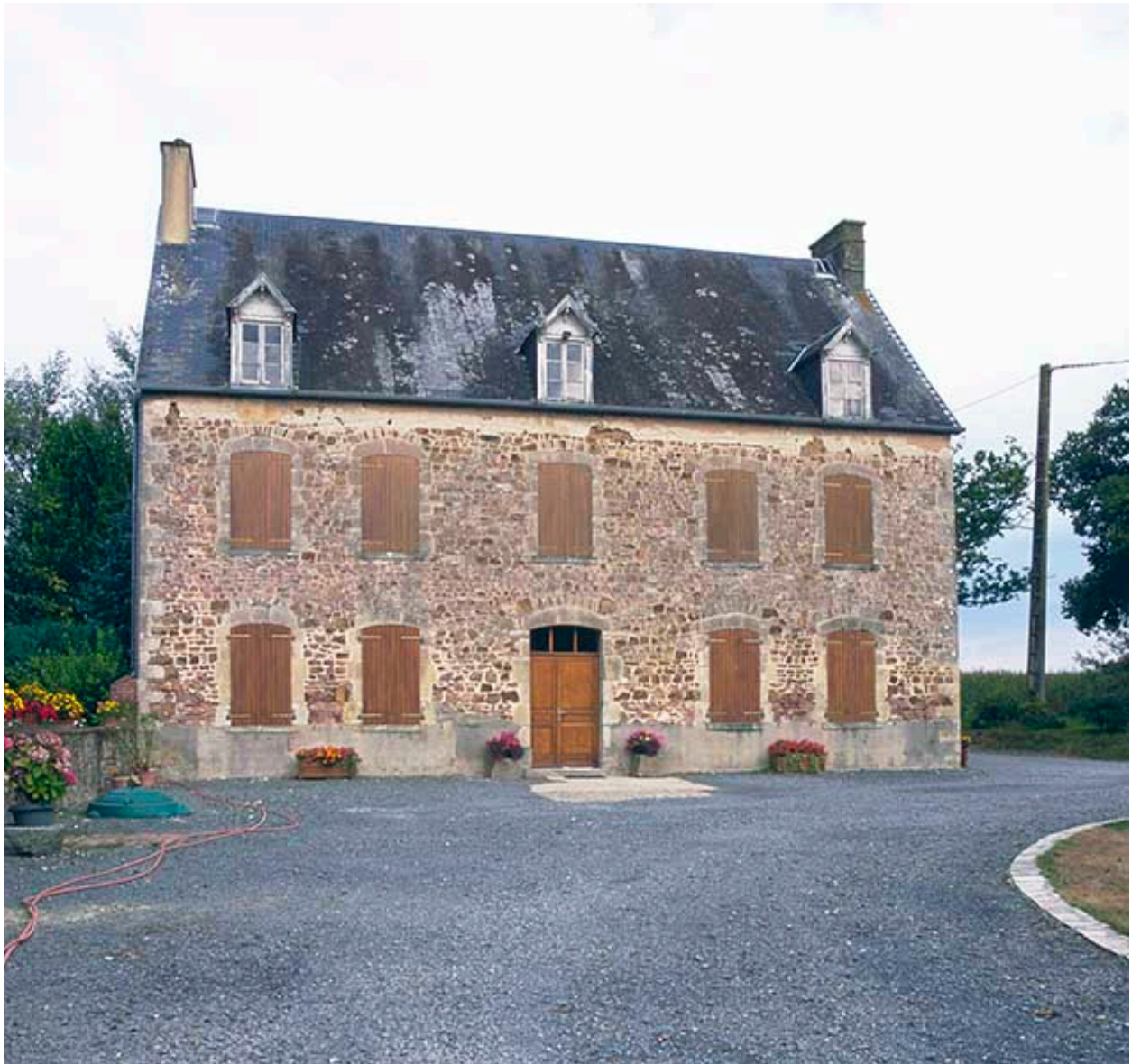
Logis, façade antérieure, vue prise du sud.
