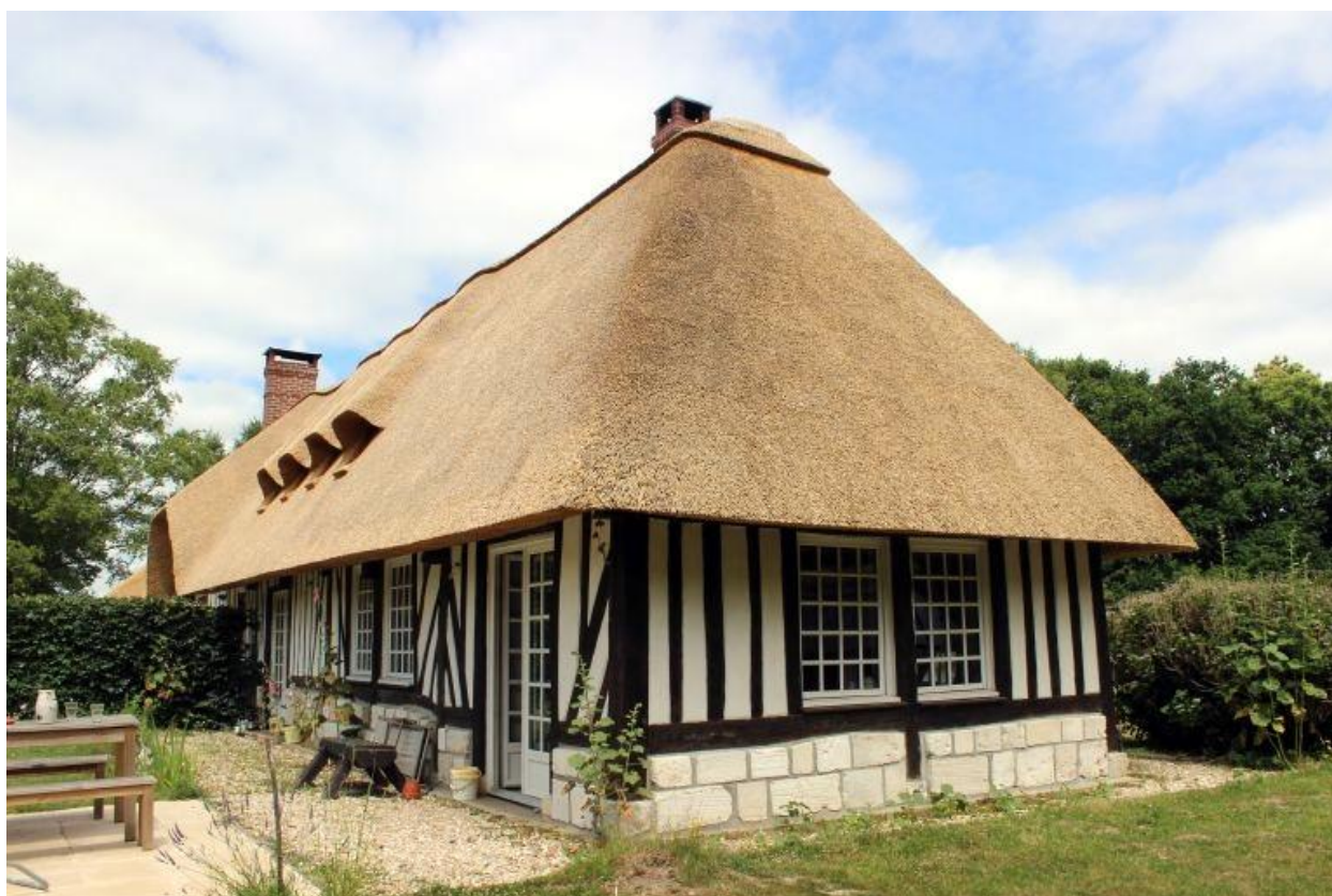
Chaumière, façade sud, angle sud-est, le bord du Mort, 1255, rue des Bruyères.
