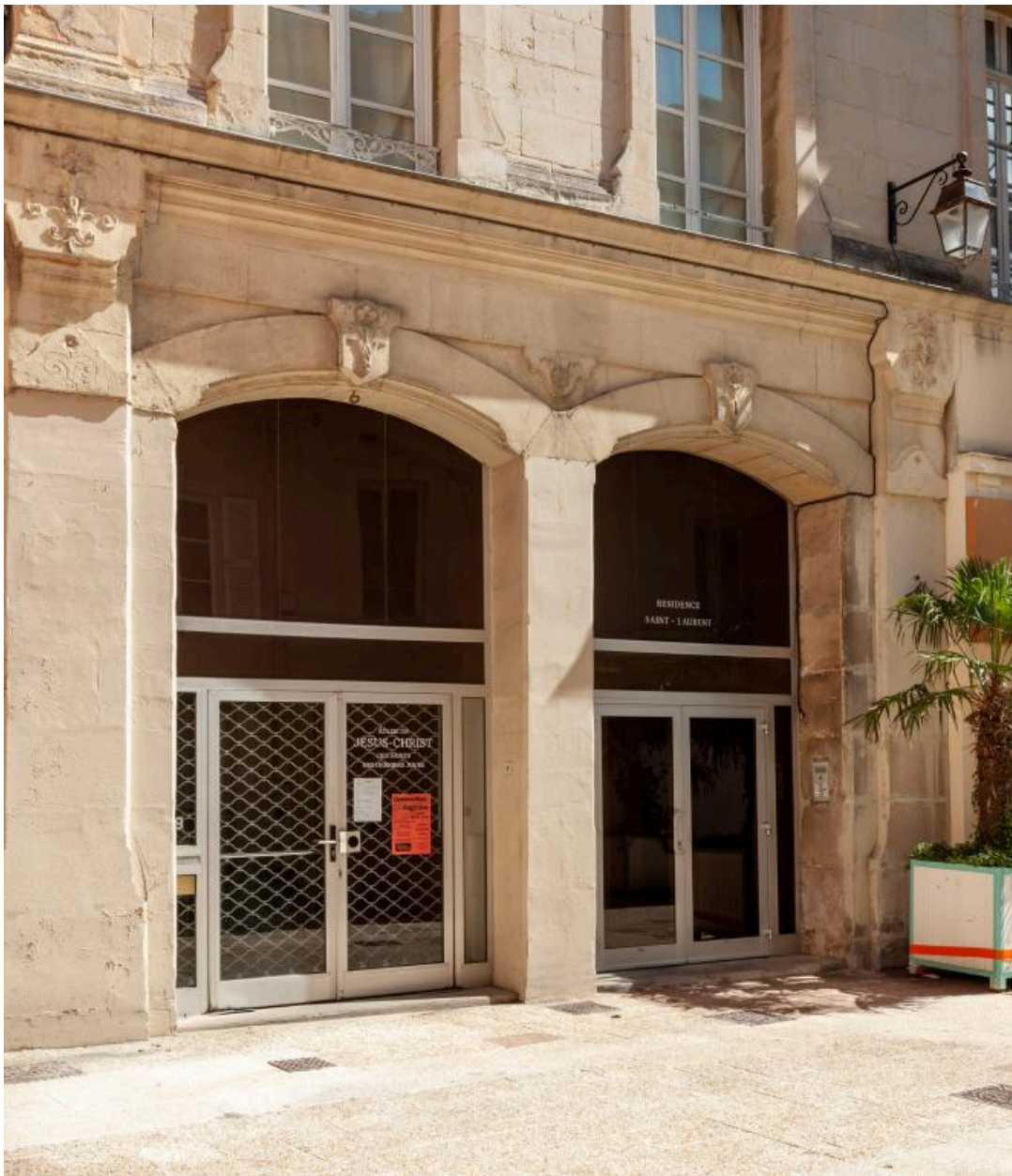
Détail de la façade sur rue : arcades du rez-de-chaussée.
