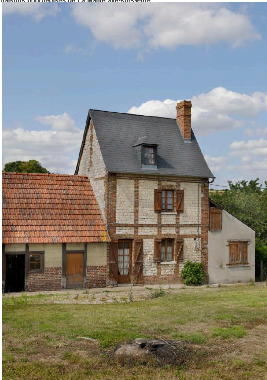
Maison à étage en brique et moellons calcaire, 1456, rue du Wuy.
