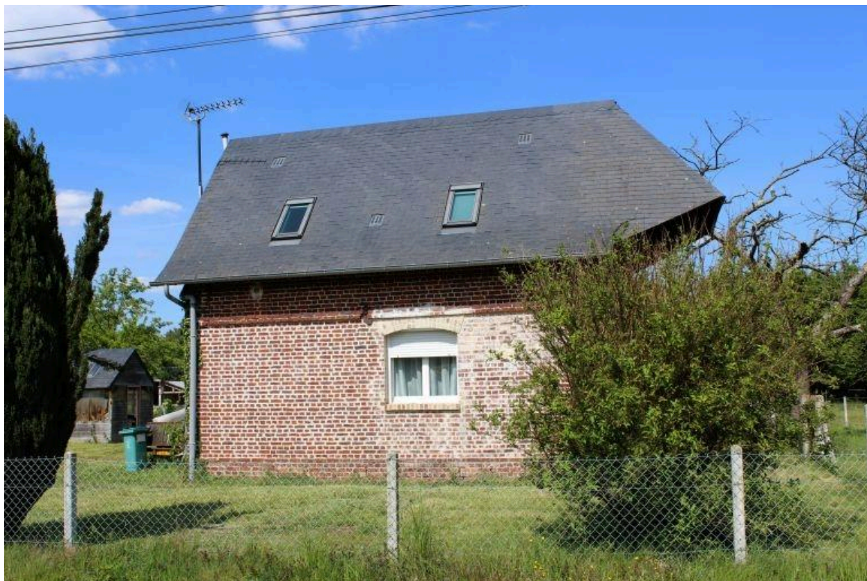
Ancien bâtiment agricole actuellement maison, le bord du Mort, rue des Bruyères.
